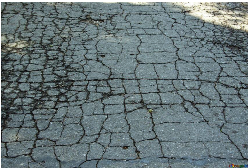
Рисунок 5 – Разрушенное покрытие территории благоустройства промышленной зоны территории Обидимского кирпичного завода
