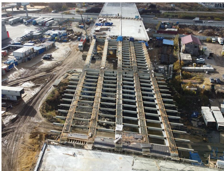
Рисунок 4 – Возведение нового путепровода из композитных материалов
