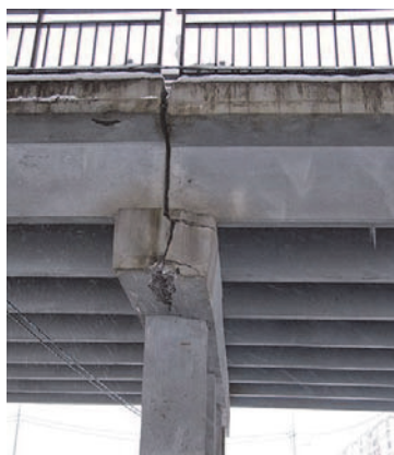
Рисунок 3 – Обрушение пешеходного моста из традиционного железобетона
