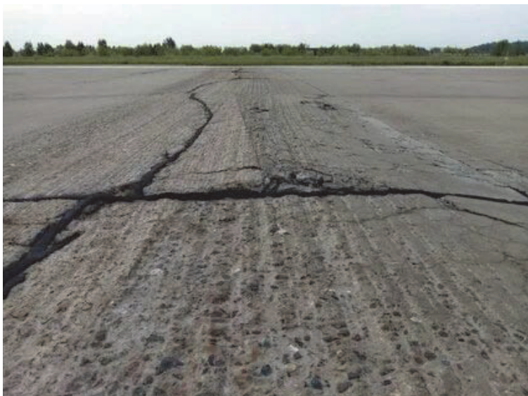
Рисунок 5 – Разрушенная взлетная полоса из традиционных материалов
