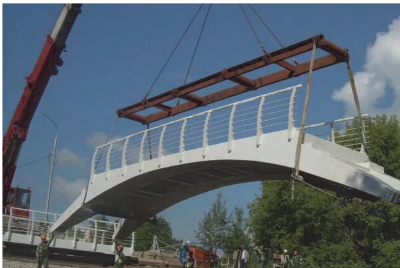
Рисунок 4 – Возведение нового пешеходного моста из композитных материалов
