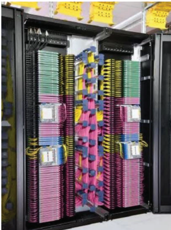
Рисунок 9 – «Безоболочечное» исполнение центрального кросса
